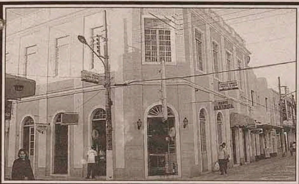
A mesma rua nos dias atuais, onde hoje funciona a Instaladora Rádio Elétrica.
